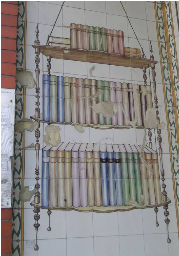
◀ Het tegeltabelau in het portiek van Havik 37 toont dat hier vroeger een boekhandel was gevestigd
