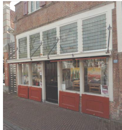
▲ Havik 33-35 bezit een etalage met luiken die in opgeklapte vorm als toonbank dienst doen. Boven de ranke luifel is een groot bovenlicht aangebracht. In dit voorbeeld is goed te zien, dat deze winkelpui door de vijf stijlen en de bovenbalk een dragende functie binnen het metselwerk bezit
