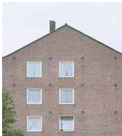
Bestaande appartementen met kap
