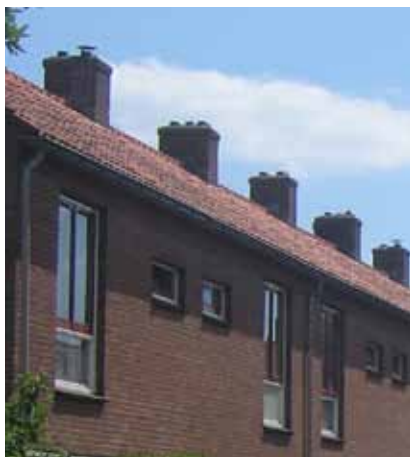
Bestaande langskap met schoorstenen
