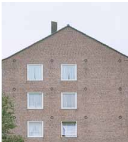
Bestaande appartementen met kap
