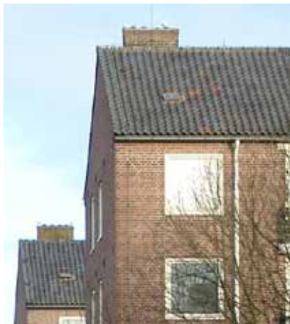
Bestaande antraciet / zwarte dakpannen
