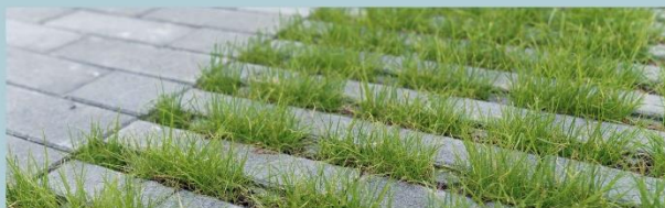
open verharding ter plaatse van de parkeerplaats, moderne materialen bieden mogelijkheden voor infiltratie en groen, maar zijn ook vlak en daarmee goed toegankelijk
