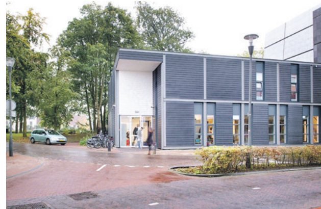
De opvanglocatie voor dak- en thuislozen aan het Smallepad voldoet niet meer aan de eisen (foto: Kwintes).
