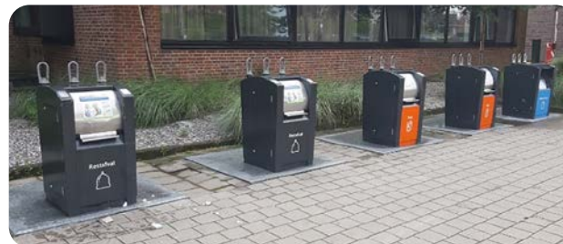
Foto 1: voorbeeld van ondergrondse verzamelcontainers
