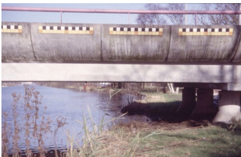
Fig. 10.48 Doorlopende oever onder brug.
