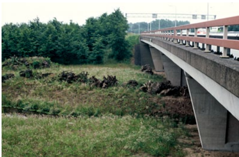
Fig 10.32 Geleiding naar de onderdoorgang kan bijvoorbeeld met stobbenwallen en een watergang.
