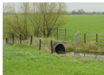
Fig. 10.111 Een dam met duiker in de sloot geeft een natuurlijker aansluiting dan een betonnen loopplank.
