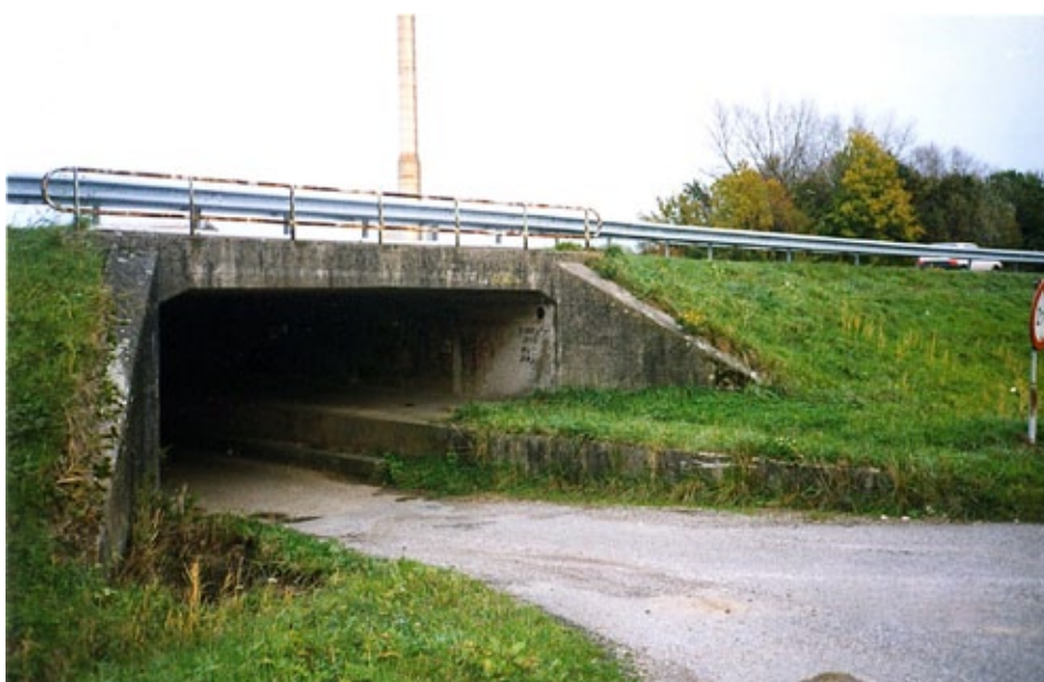
Fig. 10.51 Voorbeeld van een tunnel met twee hoogteniveaus zonder specifieke functie voor fauna waarbij in niet aangepaste vorm reeds sprake is van gebruik door dieren.
