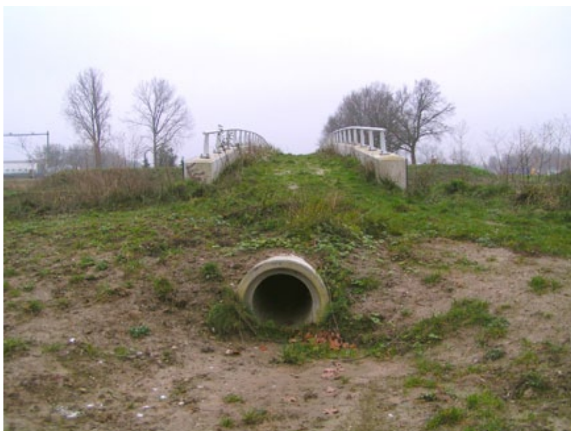
10.81 Detail van het nog onbegroeide ecomiduct: de ingang van het buisgedeelte.
