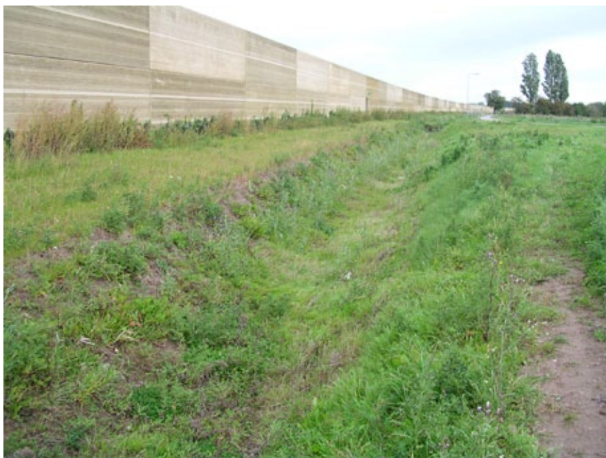
Fig. 10.154 Geluidsschermen langs de Betuweroute.
