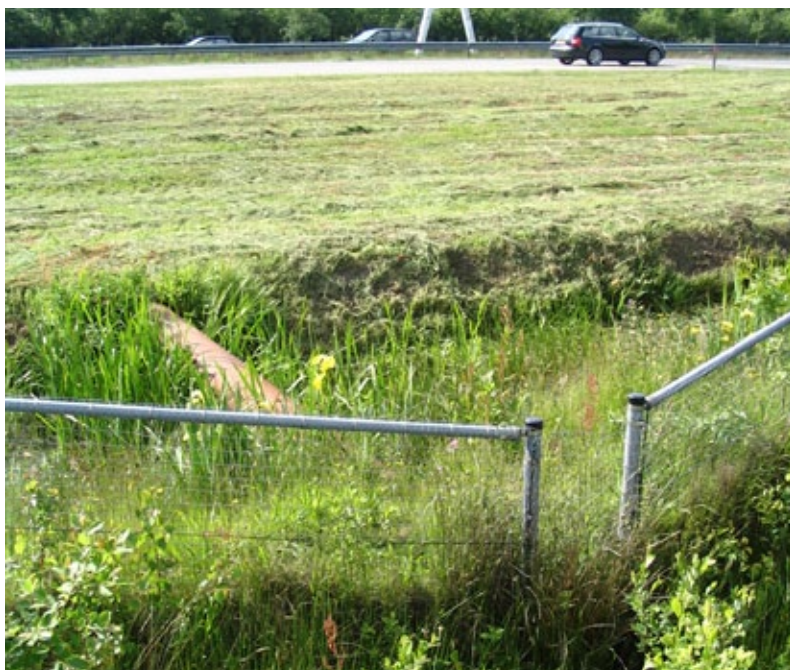
Fig 10.124 Voorbeeld van een zeer lange faunabuis (ook gedeeltelijk over de sloot/greppel getrokken) die buiten het beheersgebied van RWS begint en eindigt: voordeel voor het maaibeheer in de berm, maar de grote lengte van de buis en de onbeikbaarheid van het bermhabitat zijn nadelen
