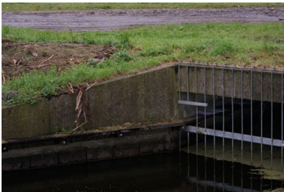
Fig. 10.114 Duiker met een loopplank en voorzien van spijlen, momenteel ongeschikt voor vleermuizen, maar indien aangepast (spijlen weg) een geschikte faunapassage voor met name watervleermuizen.
