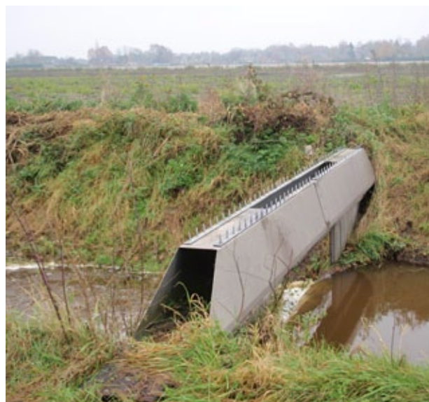
Fig. 10.172 Constructie om te voorkomen dat de loopplank door mensen wordt gebruikt.
