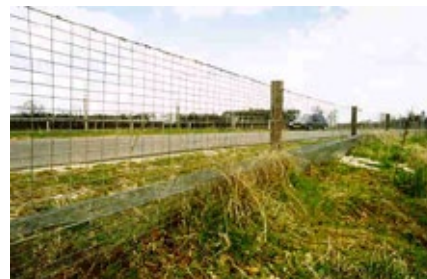
Fig 10.136 Kleinwild- en amfibieënraster; het fijnmazige raster wordt in verband met beschadiging bij onderhoud, het gemakkelijk inklimmen van dieren en de te grote maaswijdte voor jonge amfibieën bij voorkeur niet meer toegepast
