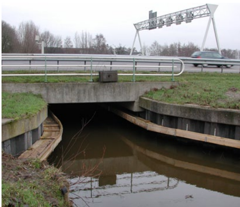
Fig. 10.108 Houten loopstroken met opstaande rand onder bestaande brug aangebracht, verbonden met de oevers .
