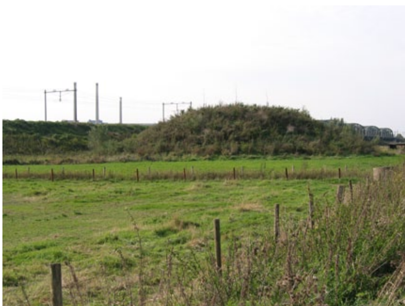
Fig. 10.176 en 10.177 Om te voorkomen dat dassen hun burcht in het talud van het spoor maken, is in de directe omgeving een terp aangelegd met een kunstburcht.
