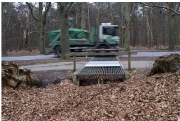
Fig. 10.164 Brede faunagoot afgedekt met een rooster voorzien van natuurlijke, maar niet goed aansluitende geleiding in de vorm van stobben.
