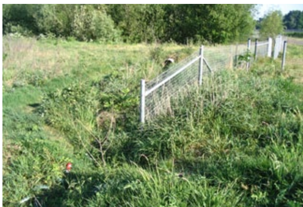
Fig. 10.139 Te kort raster, dassenwissel loopt er gewoon omheen; ook de werkpoort sluit niet goed.
