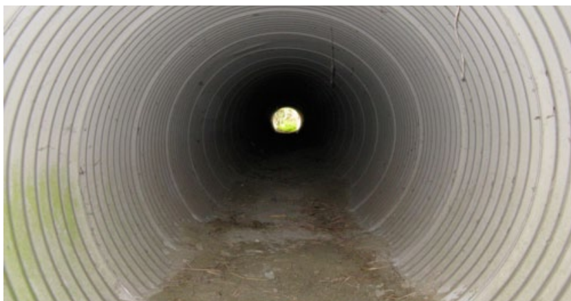
Fig. 10.68 Ronde faunapassage van spirosol.
