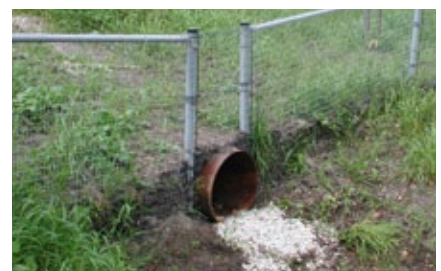
Fig. 10.74 Dassentunnel met goede aansluiting op raster.
