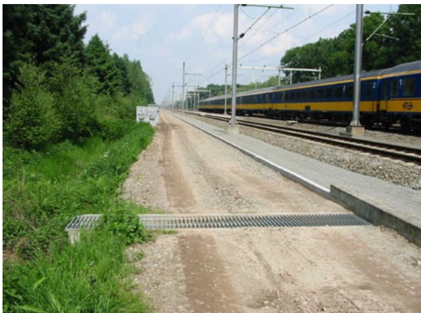
Fig. 10.59 Amfibieëntunnel onder spoor (foto: Maarten van Vuurde).
