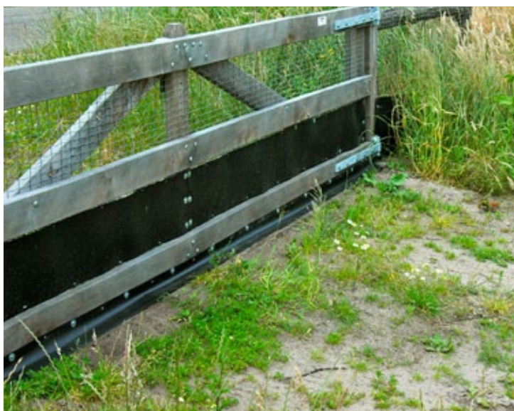
Fig. 10.134 Raster en werkpoort voorzien van dichte strook aan de onderzijde om amfibieën te keren.
