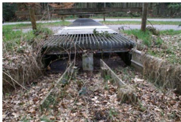
Fig. 10.167 Brede faunagoot afgedekt met een rooster voorzien van goede geleiding; begroeiing mag echter niet teveel gaan woekeren om uitklimmen van kleine soorten te voorkomen.
