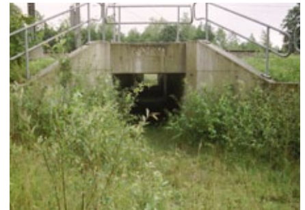
Fig. 10.66 Voorbeeld van ruim gedimensioneerde kleine faunatunnel (kleine tot middelgrote dieren).
