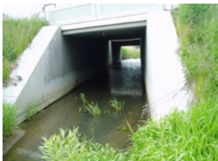
Fig 10.41 De tunnel mag niet onder water staan.
