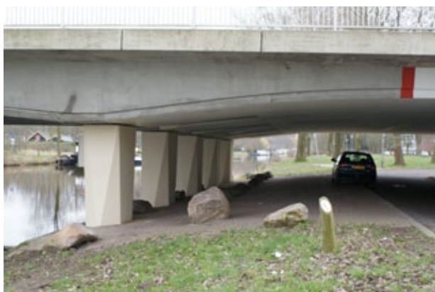
Fig. 10.165 Stenen stobben: brandpreventie en niet te verplaatsen door onverlaten.
