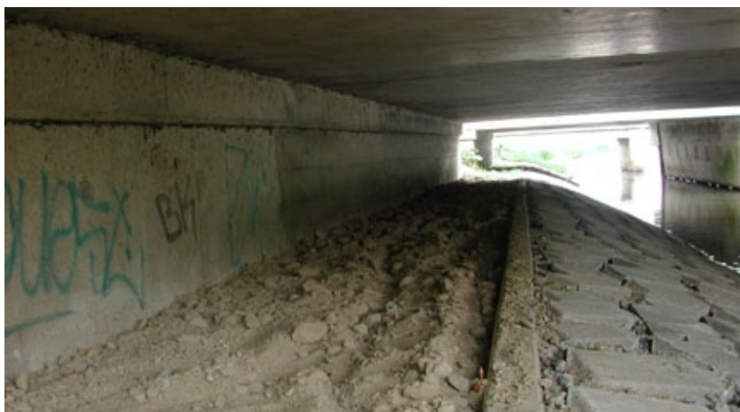
Fig. 10.47 Onverharde strook onder brug, talud met basaltblokken verstevigd.
