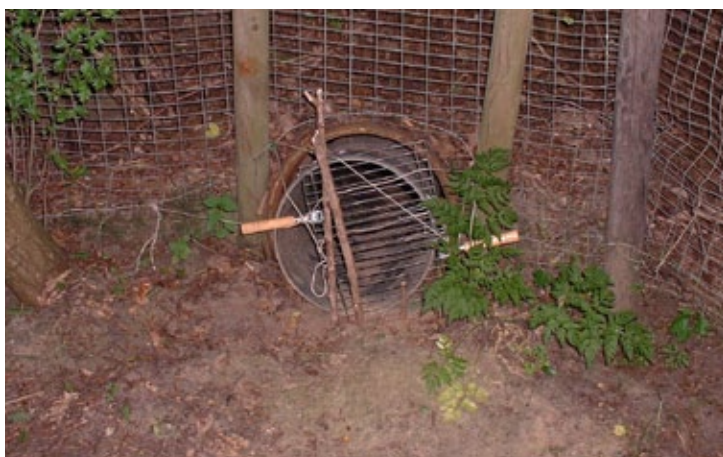
Fig. 10.130 Inspectie van faunavoorzieningen: tunnel is dichtgezet
