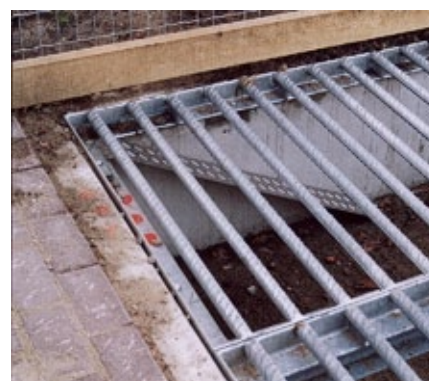
Fig 10.162 Metalen strip in wildroosterbak als uitklimvoorziening voor kleine dieren
