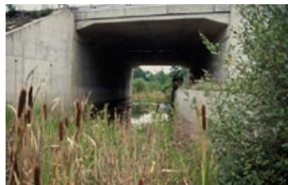
Fig. 10.46 Met een perronwand is een onverharde strook onder de brug gemaakt.
