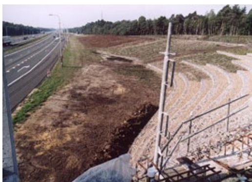
Fig 10.26 Talud opgebouwd met schanskorven
