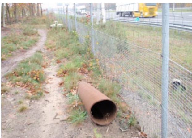
Fig. 10.142 5Raster sluit niet goed aan op de buis, kleine dieren die strak het raster volgen, kunnen de buis hierdoor missen.
