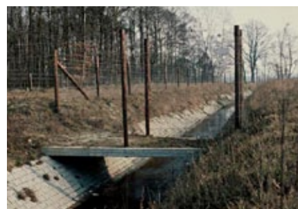
Fig. 10.174 Betonnen loopplank over sloot als aanvullende voorziening bij een dassentunnel.
