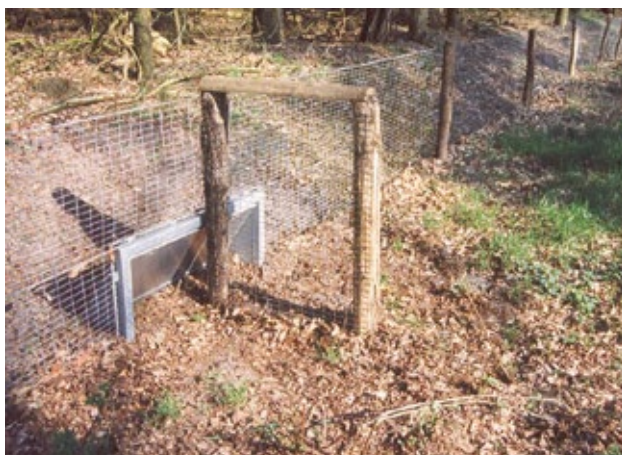
Fig. 10.138 Ingang dassentunnel waarbij de afsluiting van de inspectieput tevens als insprong dienst doet
