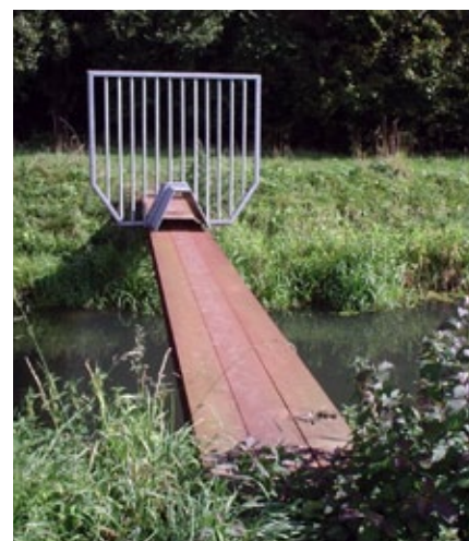
Fig. 10.173 Oversteek sloot met rooster om passage van mensen te voorkomen.
