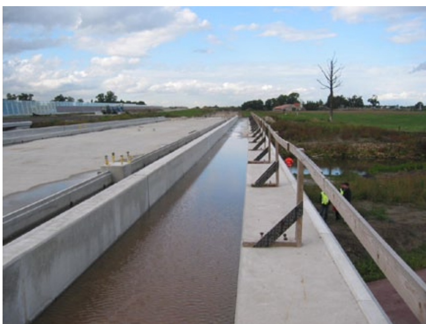
Fig. 10.98 Door de spoorbrug iets breder te maken, ontstaat ruimte voor een groenstrook voor fauna.
