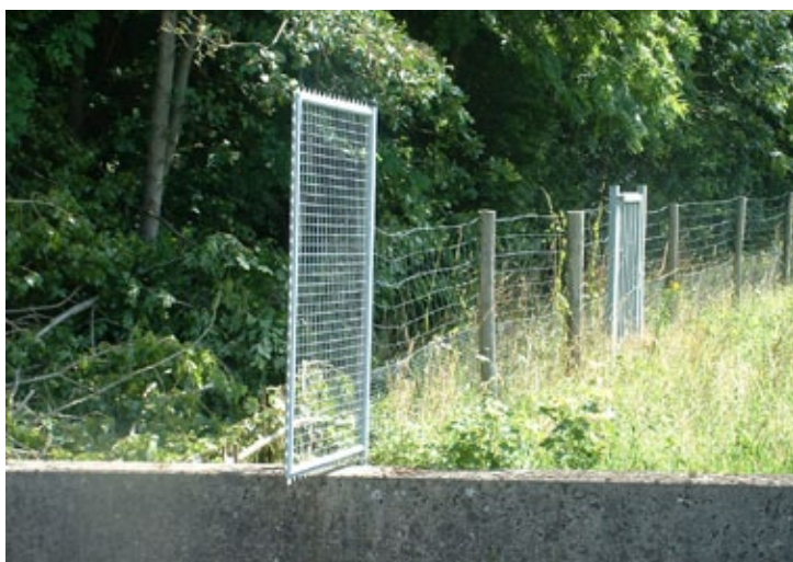
Fig. 10.131 Beëindiging raster op rand tunnelbak
