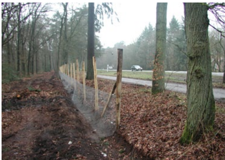
Fig. 10.129 Het raster moet worden ingegraven om gravende dieren tegen te houden (foto: Bert Stegeman).
