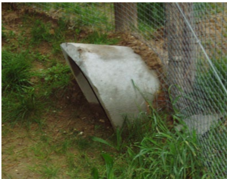
Fig. 10.72 Dassentunnel: door het schuine uiteinde zal het minder snel inregenen.
