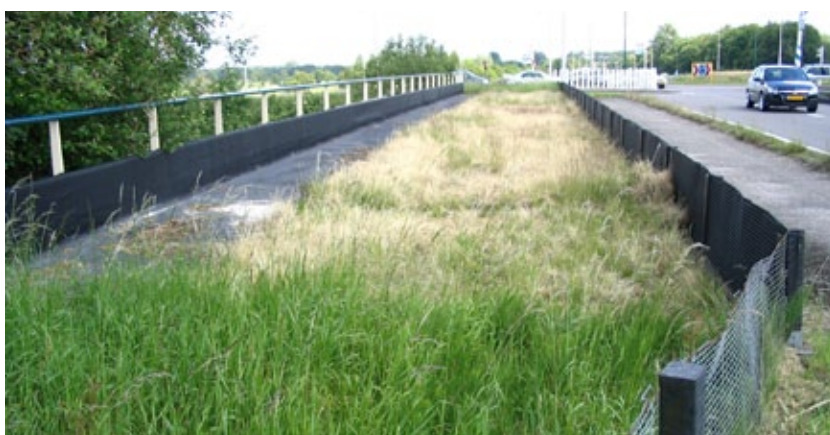
Fig. 10.95 Natuurlijk ingerichte strook op een viaduct over de A27 bij Bilthoven, bedoeld voor das en kleine zoogdieren: de schermen verhinderen verlichting van de strook door het passerende verkeer boven- en onderlangs.
