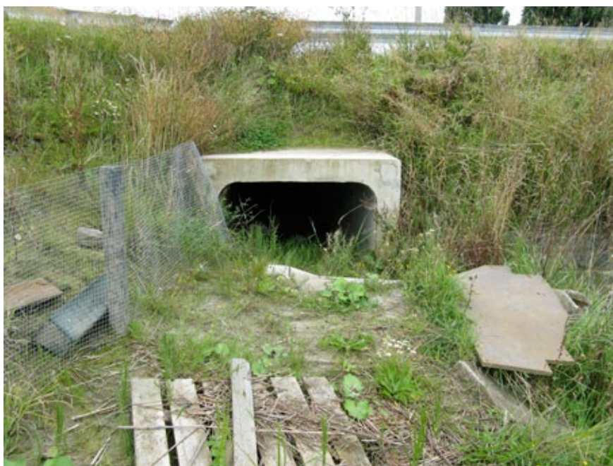
Fig. 10.146 Rommelige aansluiting.
