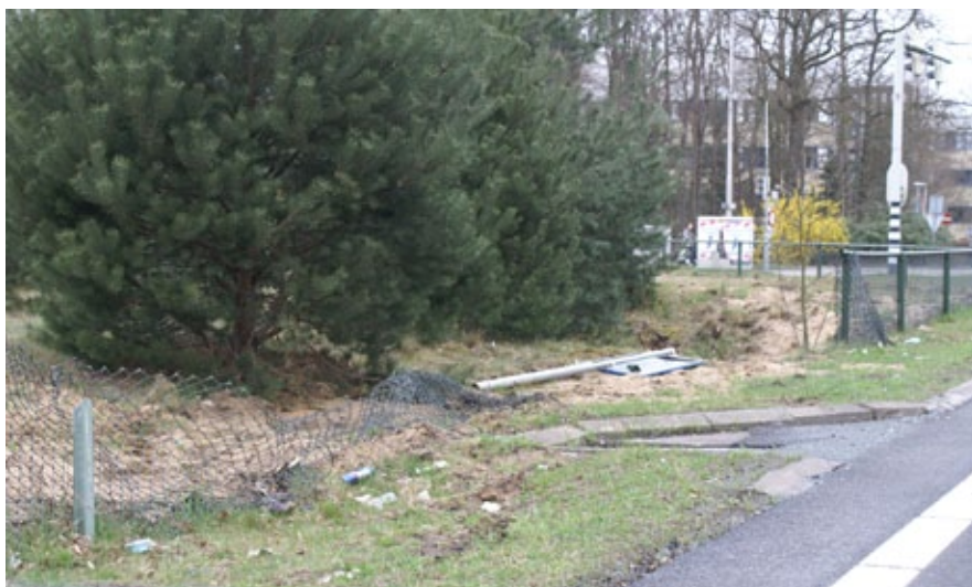
Fig. 10.145 Verwoest raster na een aanrijding.
