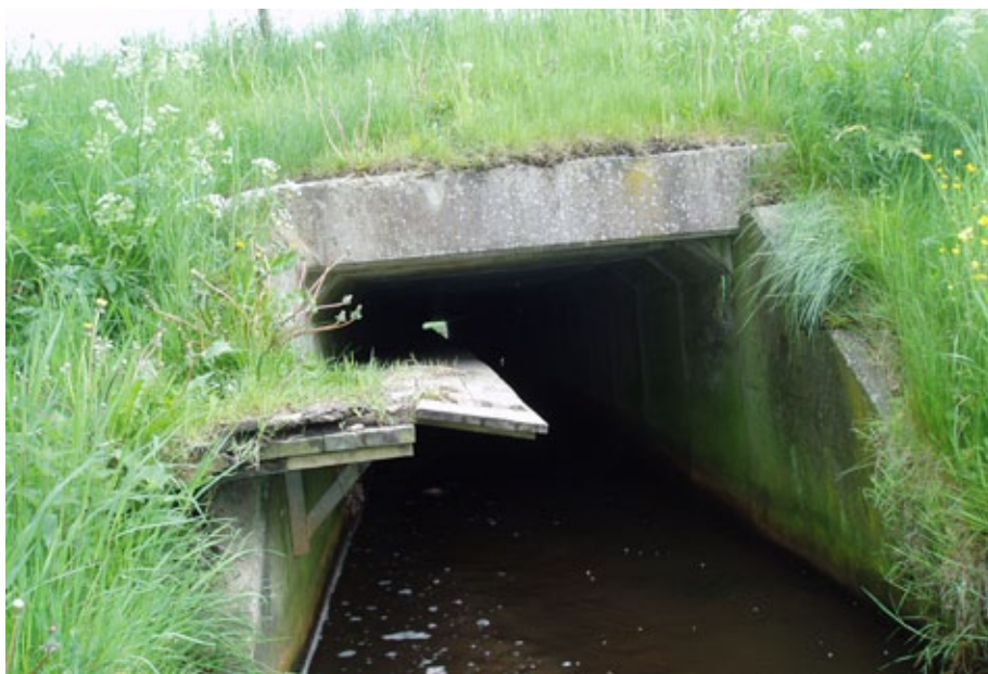
Fig. 10.115 Nadeel van een houten loopplank is dat die snel verrot en daardoor veel onderhoud vergt en of regelmatig moet worden vervangen.
