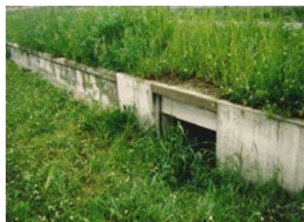
10.78 Ingang amfibieëntunnel met betonnen geleidingswand, rechthoekige tunnels hebben de voorkeur.
