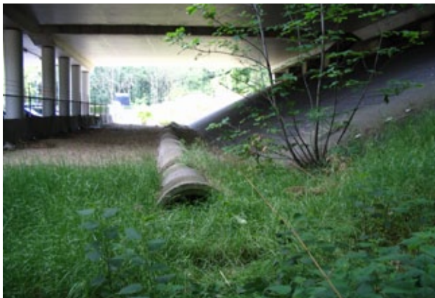
Fig. 10.144 Buis zonder aansluitende geleiding; locatie lijkt ook zonder deze buis prima te kunnen functioneren als faunapassage.
