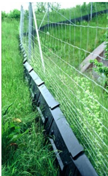
Fig 10.132 Amfibieënscherm en raster voor kleine respectievelijk grote dieren
