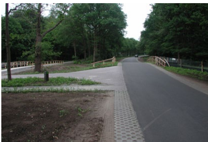
Fig. 10.149 en 10.150 Een voormalige rijksweg (80 km/u) is met een middengeleider en een verhoging ter hoogte van de beek tot een 60 km/u weg omgebouwd (foto's: Bert Stegehuis).
