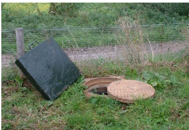
Fig. 10.160 Inspectieput met goed afsluitbare deksel, putdeksel type zwaarverkeer is niet waterdicht; waterdicht maken met stalen deksel die past om gehele gietijzeren putgedeelte
