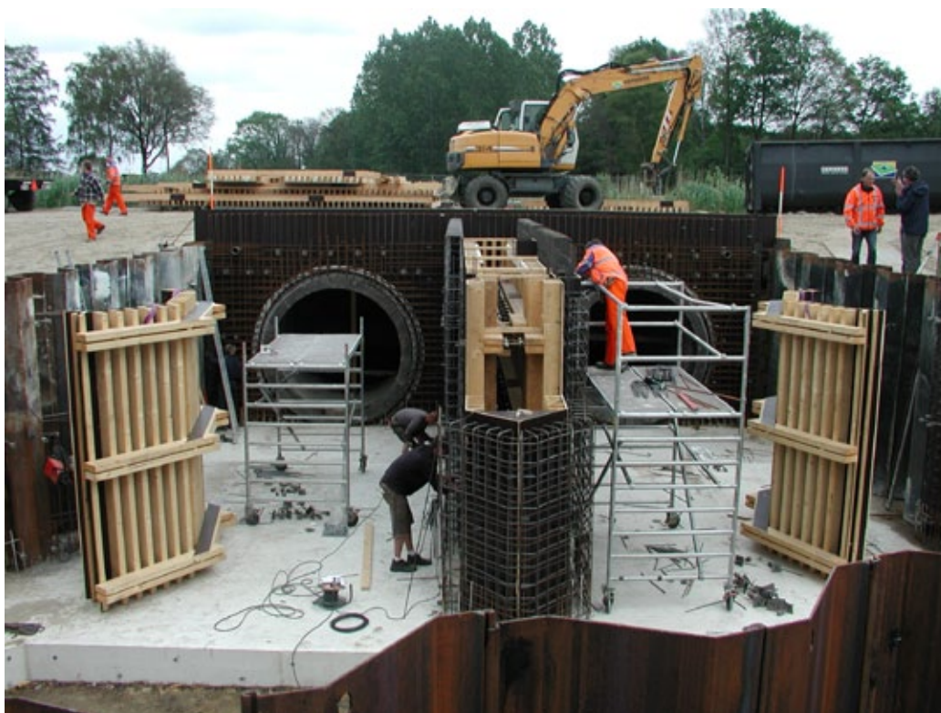
Fig 10.121 Aanleg van twee sifons onder het Twentekanaal (foto: Bert Stegehuis).
