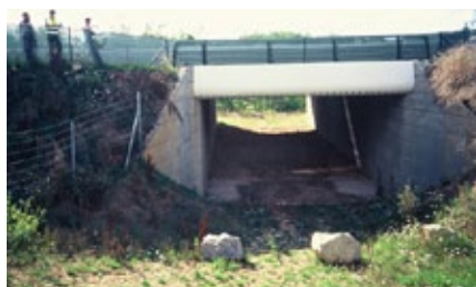
Fig 10.42 Faunatunnel voor middelgrote dieren (ree), de grote stenen dienen om ongewenst medegebruik tegen te gaan.
