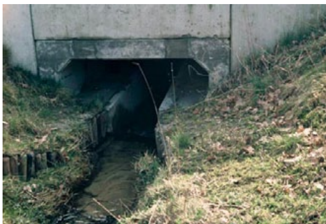
Fig. 10.56 Ecoduiker met aan beide zijden een loopstrook waarin grond is aangebracht.
