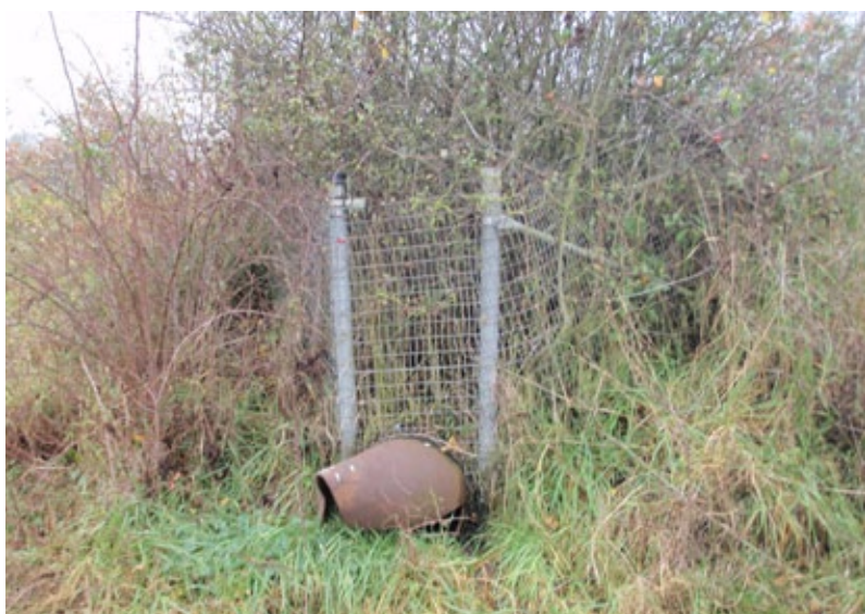
Fig. 10.76 Door aanrijding ingeklapte buis.
