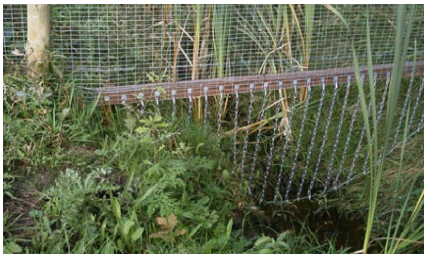
Fig. 10.122 Raster loopt door over sloot. De kettingen voorkomen passage langs de sloot
