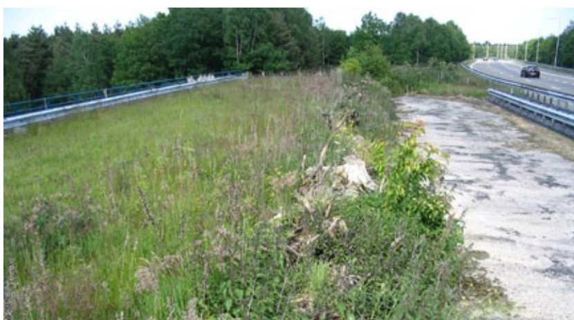
Fig. 10.94 Brede natuurlijk ingerichte strook op een viaduct over de A27 bij Hilversum: rechts van de stobbenwal is de strook verhard gelaten om het gebruik van de begroeide linkerzijde van de stobbenwal te stimuleren.
