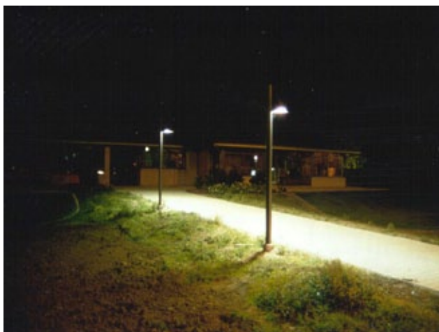
Fig. 10.155 Goed afgeschermd armatuur. Het licht schijnt alleen naar beneden.
