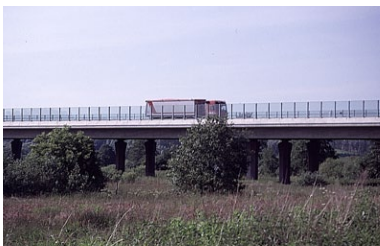
Fig 10.30 Groot viaduct (Mecklenburg - Vorpommern).
