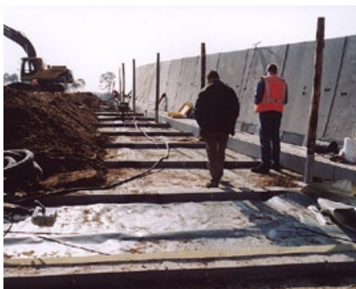
Fig 10.24 Bovenop het ecoduct zijn betonbalkjes gelijmd om water vast te houden, zodat vocht langer beschikbaar blijft voor de begroeiing (De Borkeld, A1)
