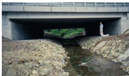
Fig 10.40 Een waterloop door de tunnel zorgt voor extra geleiding en vergroot het aantal soorten dat de tunnel kan gebruiken.
