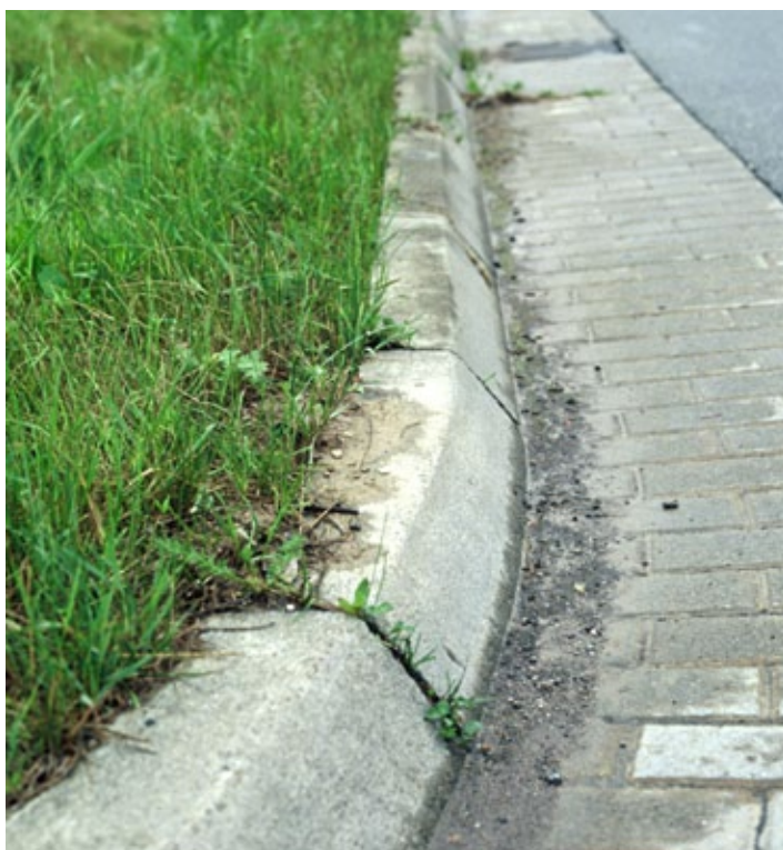
Fig. 10.175 Amfibievriendelijke trottoirband
