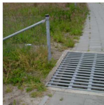
Fig 10.163 Raster sluit niet goed aan op wildrooster
