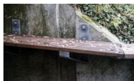
Fig. 10.110 Een degelijke bevestiging van de loopplank bevordert het duurzaam functioneren als faunapassage.
