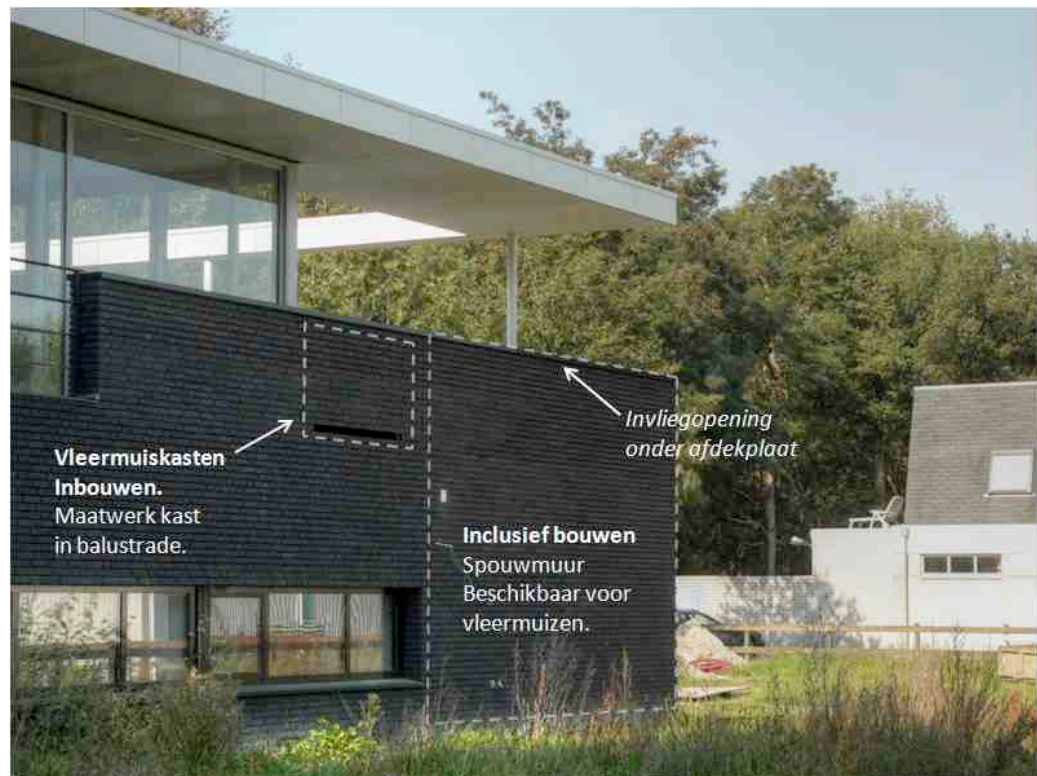
Foto 4.11 Bij inclusief bouwen worden grote delen van spouwmuren speciaal ingericht voor vleermuizen.
